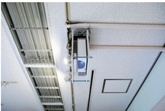
▲プロジェクターを天井に垂直設置
